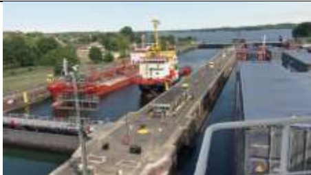
Kanalsteurer auf dem NOK
